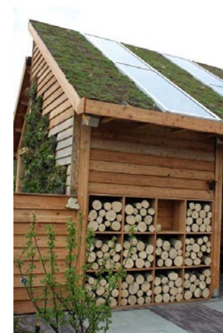
Piharakennukseen integroidut aurinkopaneelit ja viherkatto Kuva: Tuinieren.nl
