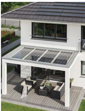
Vesikatolle asennetut ja pergolaan integroidut aurinkopaneelit Kuva: weberhaus.co.uk
