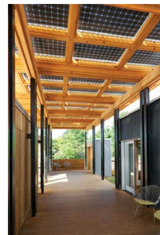
Katokseen integroidut aurinko- paneelit Kuva: Jim Tetro, Solar Homestead
